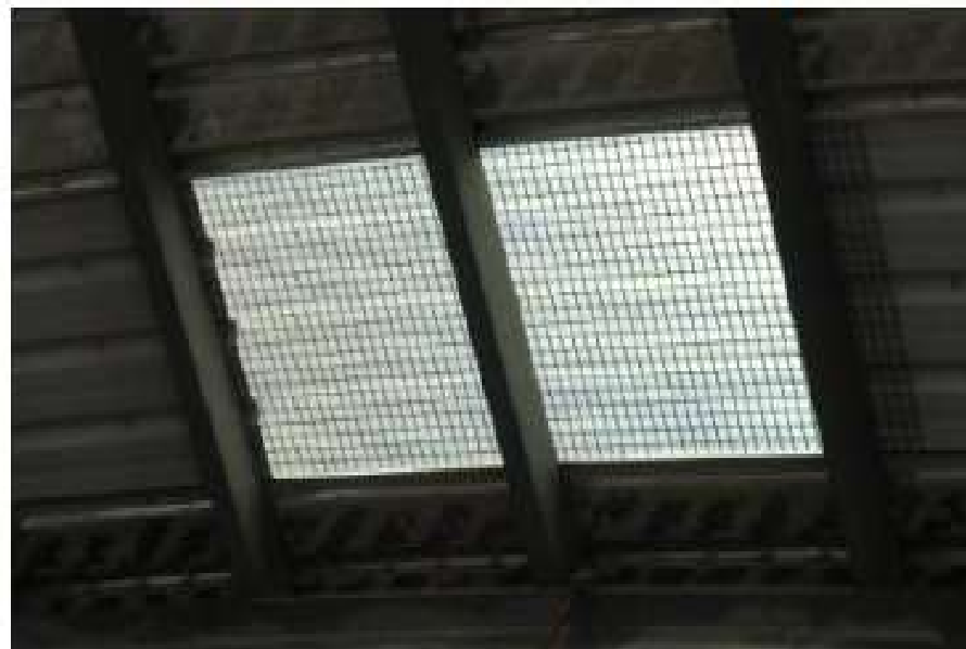
【傳統採光浪板下方加設格柵網】
