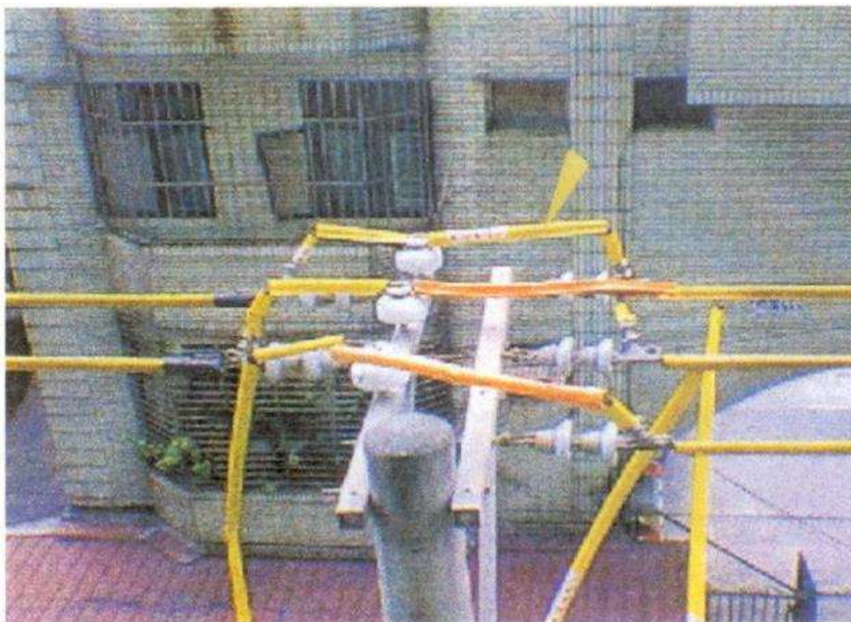
鄰接高壓電線包覆絕緣套管
